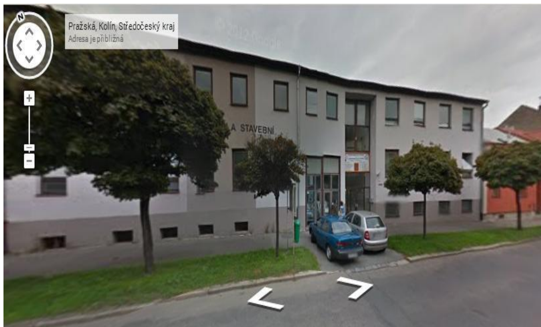
Obrázek 1. 01: Jihovýchodní průčelní pohled v barvě béžové a světle fialkové
