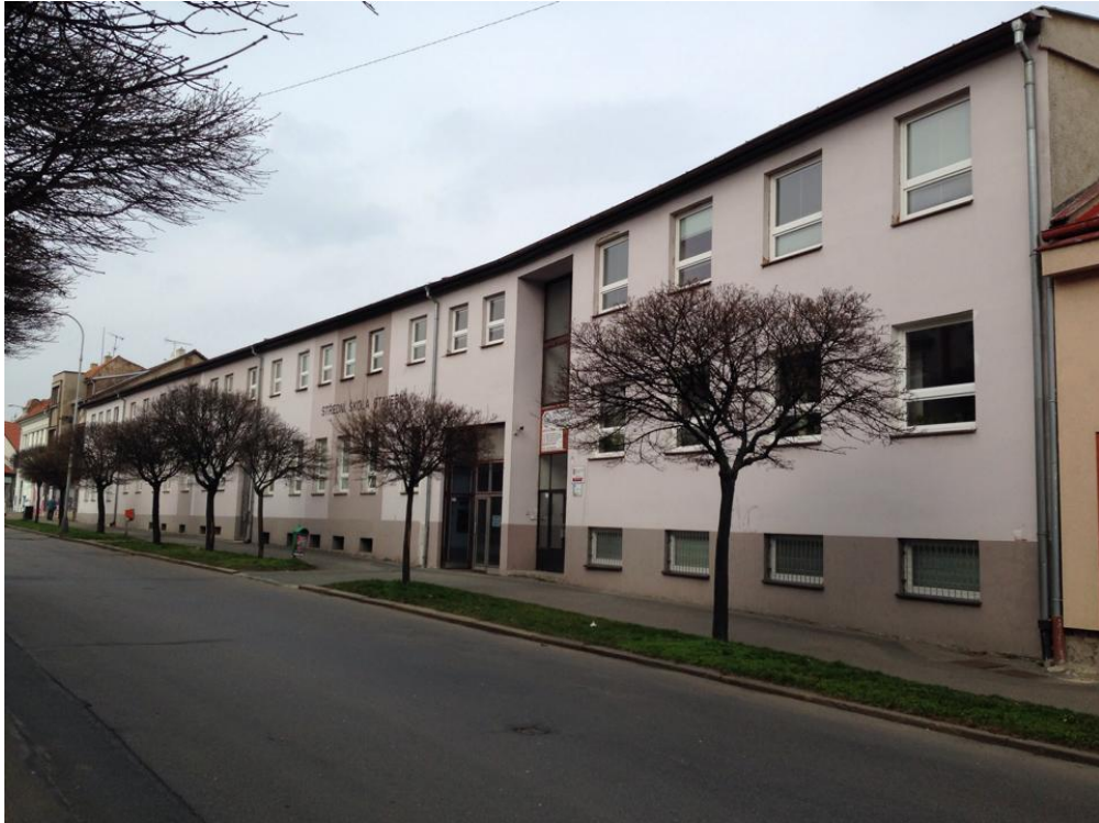
Obrázek 1. 02: Pohled na průčelní budovu z ulice Pražská
